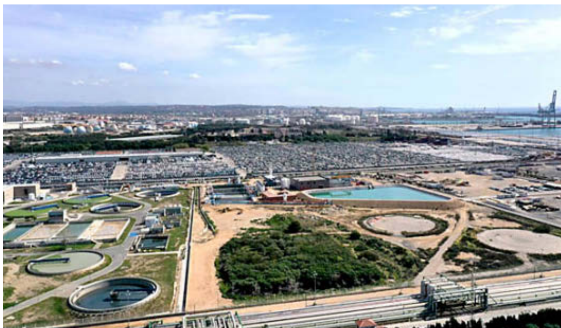
Aqualia ha diseñado y construido la Estación Depuradora de Aguas Residuales Industriales de Aitasa, que actualmente opera en Tarragona.
