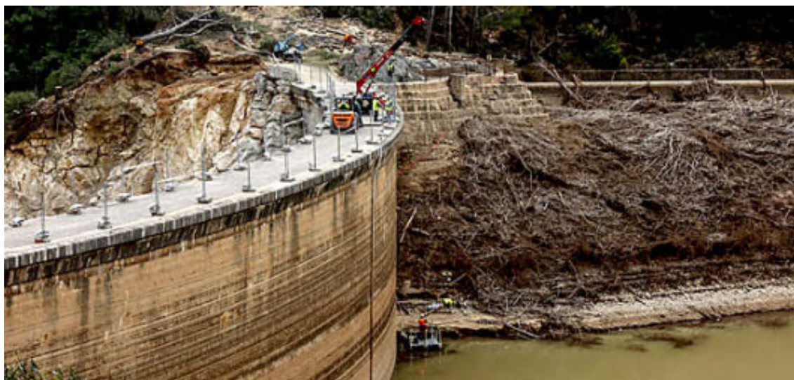
Las obras de reparación de la presa de Buseo, en Valencia, se alargarán durante meses. Europa Press
